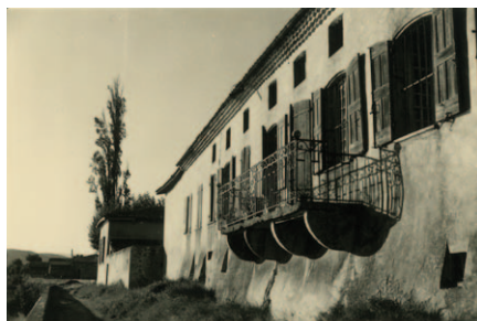
Anonyme, Moly-Sabata, façade sur le Rhône , première moitié du 20 e siècle, photographie, archives privées © Tous droits réservés
